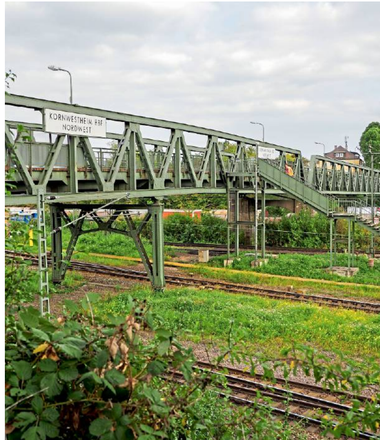
Die Tage der Pflugfelder Brücke sind gezählt.
